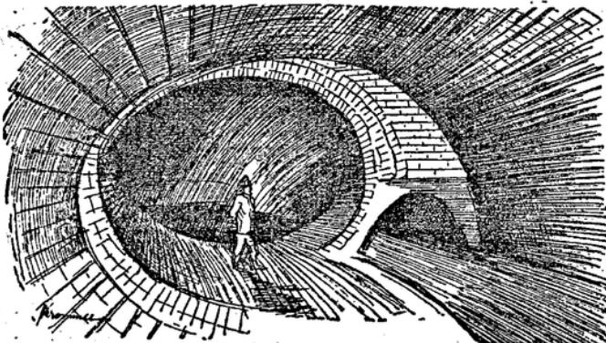
Unterdrückung des Riesenauslasses bei den übereinanderliegenden Untergrundbahnhöfen am Nollendorplatz in 14 m Tiefe und 4,20 m lichter Weite
