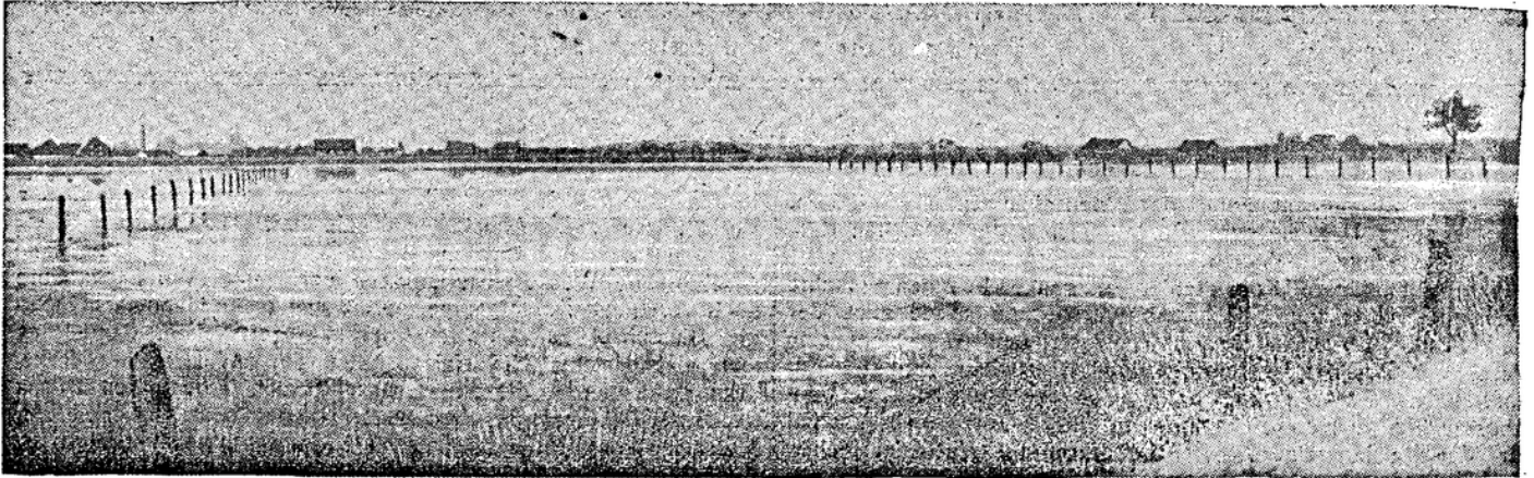
Abb. 2. Kleine Emmscher in Altenessen. Senkungssumpf westlich der Essen-Horster-Straße
